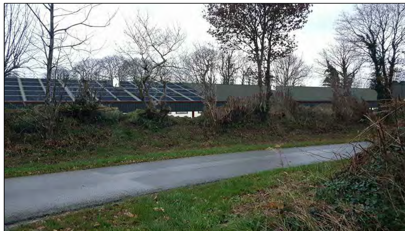
IMAGE D'INSERTION AU SOL APRES TRAVAUX
