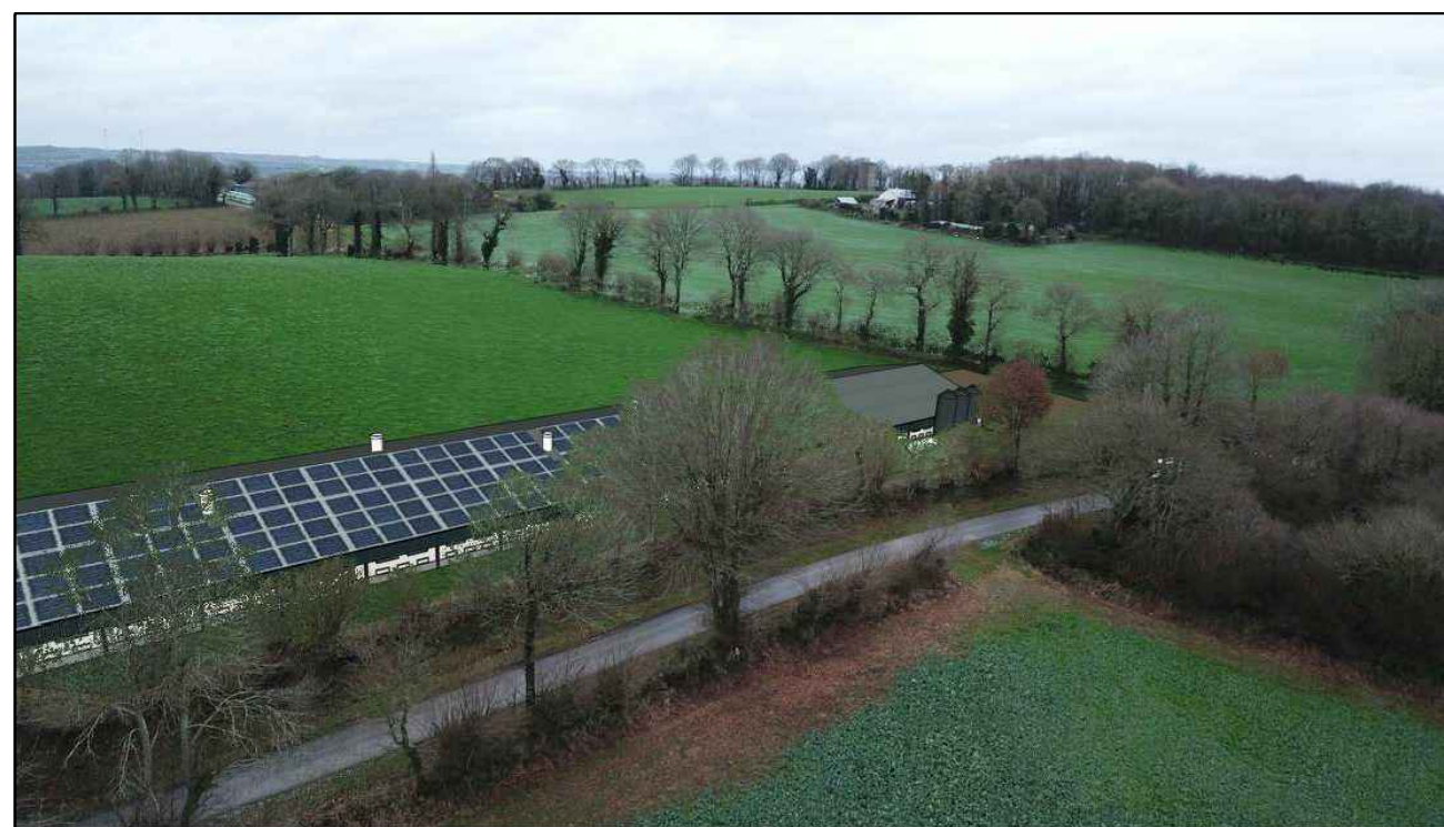
IMAGE D'INSERTION AERIENNE APRES TRAVAUX
